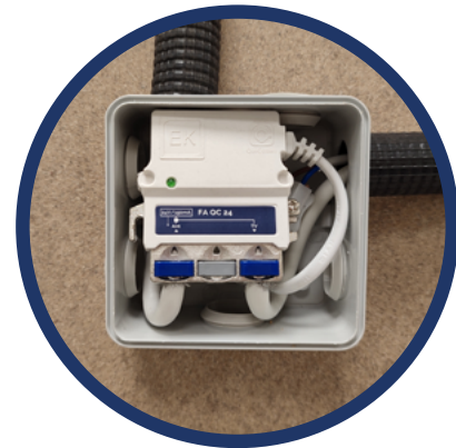
Instalação em caixa de 80 x 80mm
