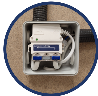
Exemple d'installation dans un boîtier de dérivation 80x 80 mm
