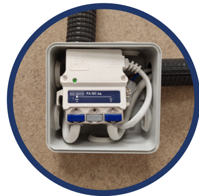
Instalación en caja de 80 x 80mm
