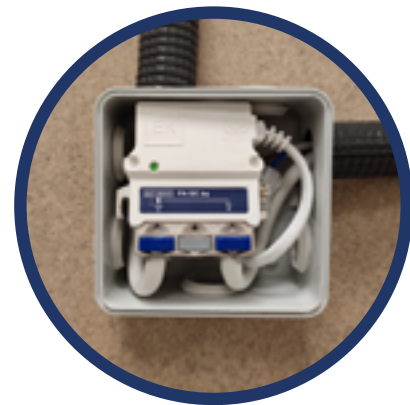
Instalación en caja de 80 x 80mm
