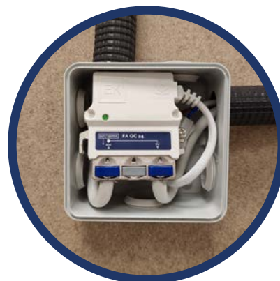
Instalação em caixa de 80 x 80mm
