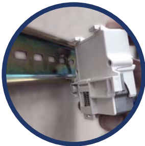
Ejemplo de fijación en carril DIN
