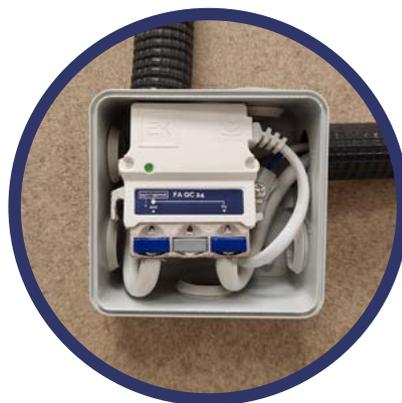
Installazione in scatola di derivazione da 80 x 80mm senza connettori F
