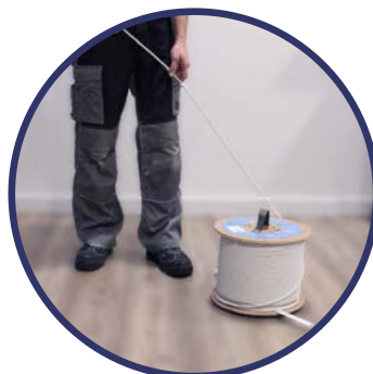
DEROULEMENT DU CABLE EK ROLLER
