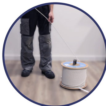
DEROULEMENT DU CABLE EK ROLLER
