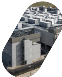
DATA CENTER TELEFÓNICA Madrid
