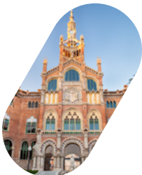
Hôpital de Sant Pau Barcelone
